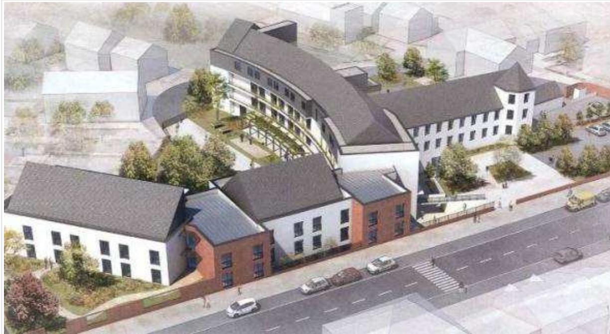
L'établissement pour personnes âgées Vuidet est en pleine transformation. Une première tranche de travaux de réhabilitation et d'extension est en cours.
